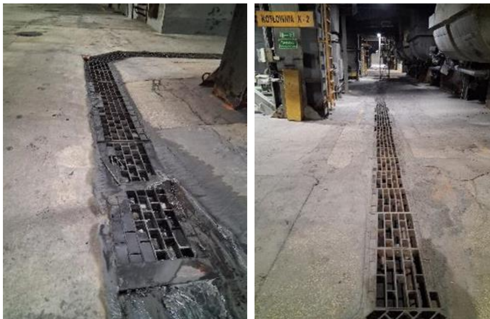
Zdjęcia nr 1-2. Istniejąca kanalizacja przemysłowa w rejonie K-2, K-3
