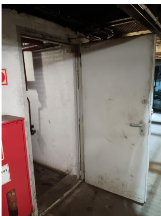
Zdjęcia nr 35-36. Obecne drzwi ppoż. w maszynowni – olejarnia TG-2
