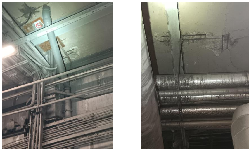
Zdjęcia nr 15-16. Lokalne uszkodzenia stropu żelbetowego
