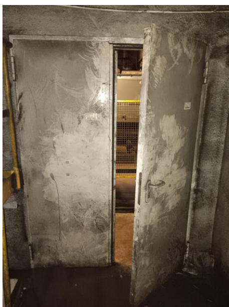
Zdjęcia nr 43-44. Obecne drzwi ppoż. na klatce schodowej wieży przesypowej W6 (przy przenośnikach taśmowych)
