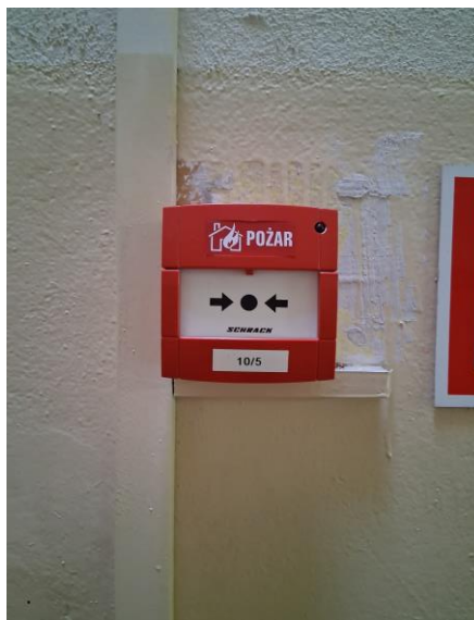
Zdjęcia nr 9-10. Aktualna klapa oddymiająca wraz z wyłącznikiem SOP
