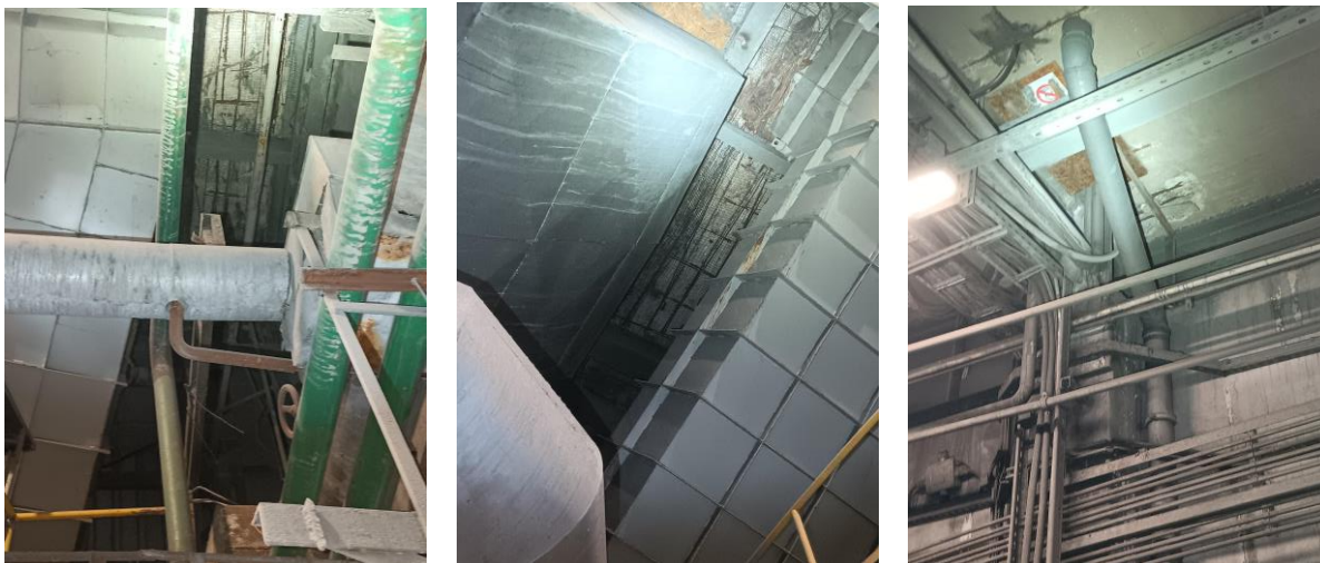
Zdjęcia nr 12-14. Uszkodzony strop żelbetowy zabezpieczony siatką
